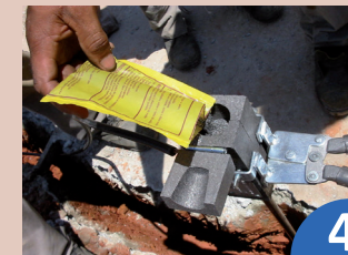
4 Agitar el cartucho para obtener una mezcla homogénea
