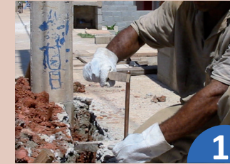
1 Secar y limpiar los conductores
