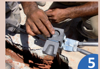
5 Sobre el compuesto disperse el polvo de ignición, dejando un rastro en la borda
